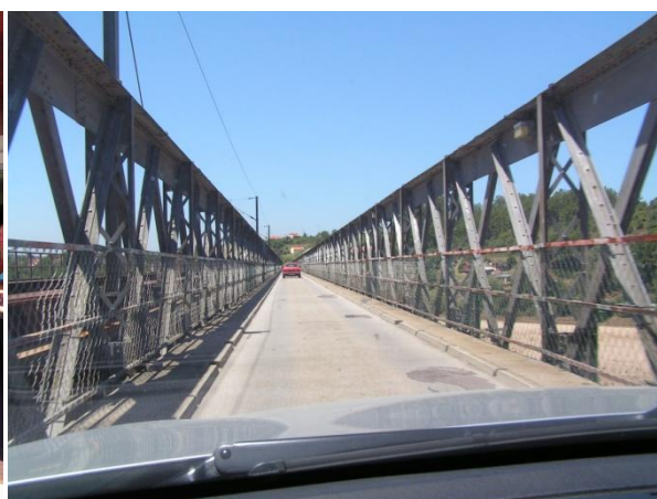
Fot. 50. Most Ponte da Chamusca na rzece Tag. (foto autor)
